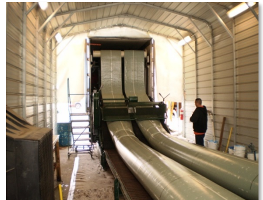
Manteca CIPP Rehab
